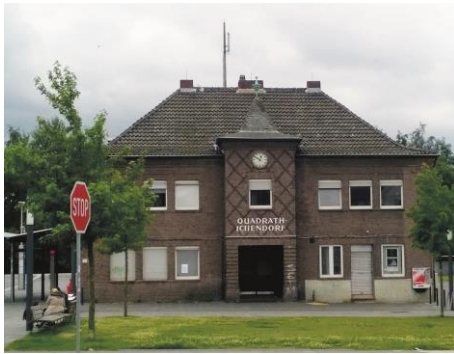
Abbildung 9: Bahnhofsgebäude Quadrath-Ichendorf (Quelle: eigene Aufnahme)
